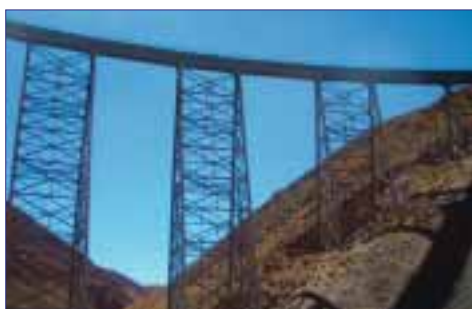
Viadukt bei San Antonio
